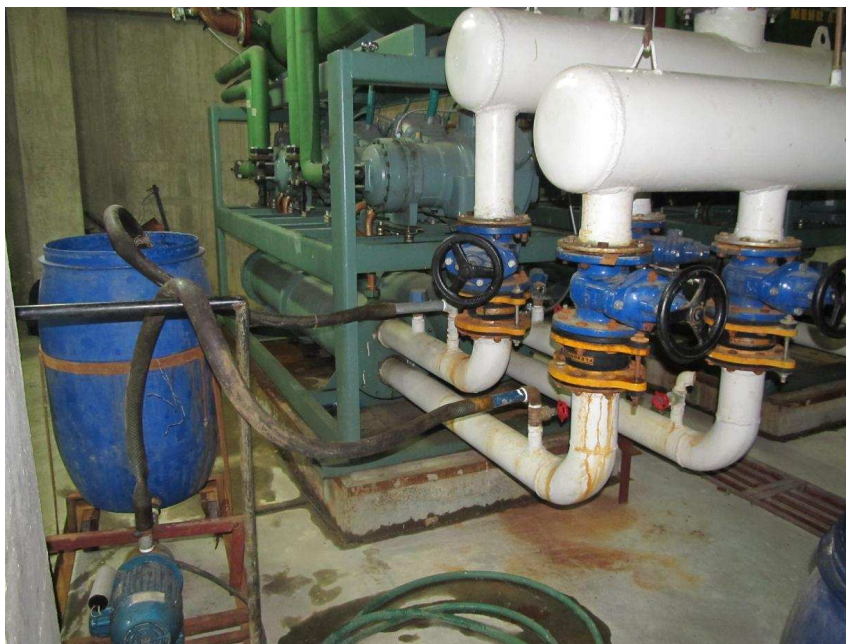
شکل 3- نمونه ای از یک چیلر در هنگام اسید شویی کندانسور مربوطه
